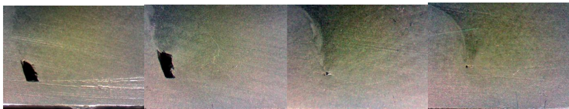
Рис. 9. Макрошлиф темплетата №2 с дефектом типа “заглаженный непровар”
